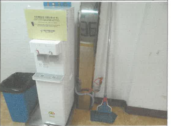
수영장 로비 정수기 연결 밸브. 누수로 릿빨 .밸브 교체
