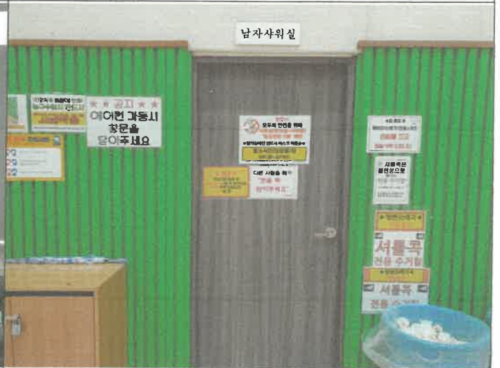
체육관 남녀 샤워실 출입문 도어락 교체
