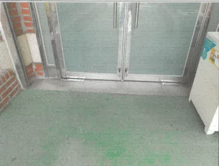
1층 주차장 출입 문 도어 스토퍼 탈거 되어 제설차
