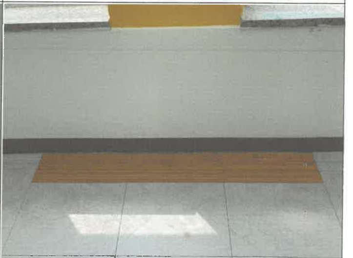
유스1,2,3,5실 환코일 배관절단 바닥 데코타일 부착
