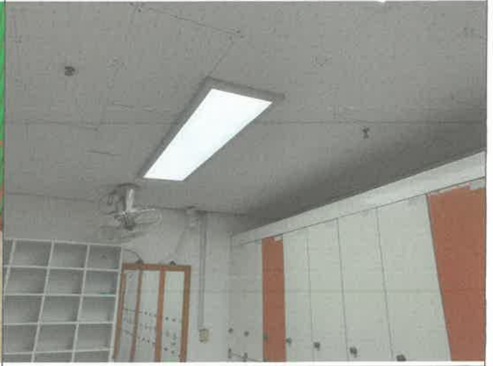
수영장 여자 탈의실 등기구 1기 교체
