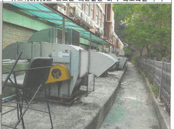
건물후면 각종 배기팬 점검 및 구리스 주입
