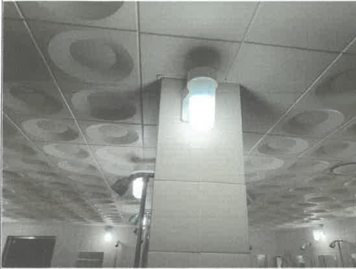
수영장 여자 샤워장 벽등 1개소 전구 교체
