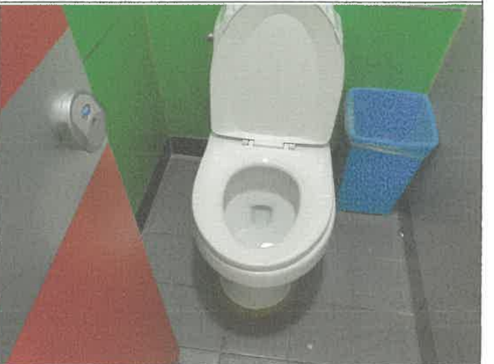
3층 여자 화장실 대변기 통수
