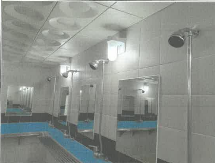
수영장 남자 샤워장 벽등 1개소 전구 교체
