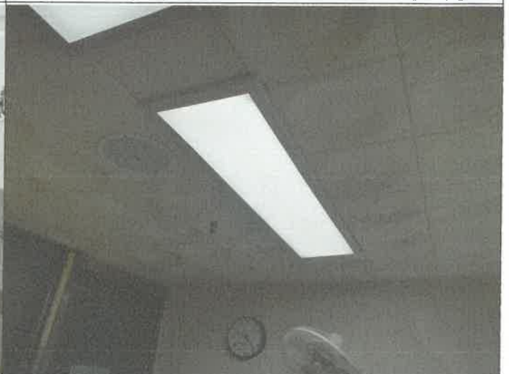
수영장 강사 대기실 천장 매립등 점등 불량 커넥터 교체
