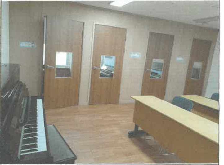
3층 아마테우스 개인 연습실 4개소 출입문 시건장치 기능 교정
