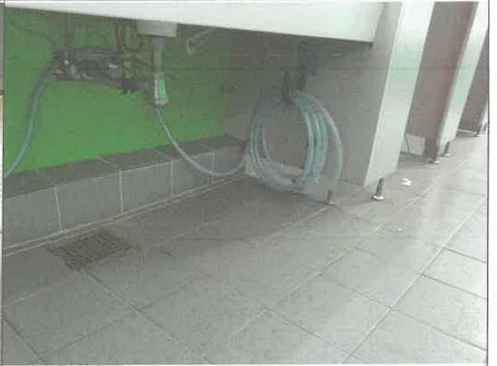
2층 3층 남. 여. 화장실 청소용 호수 교체 설치
