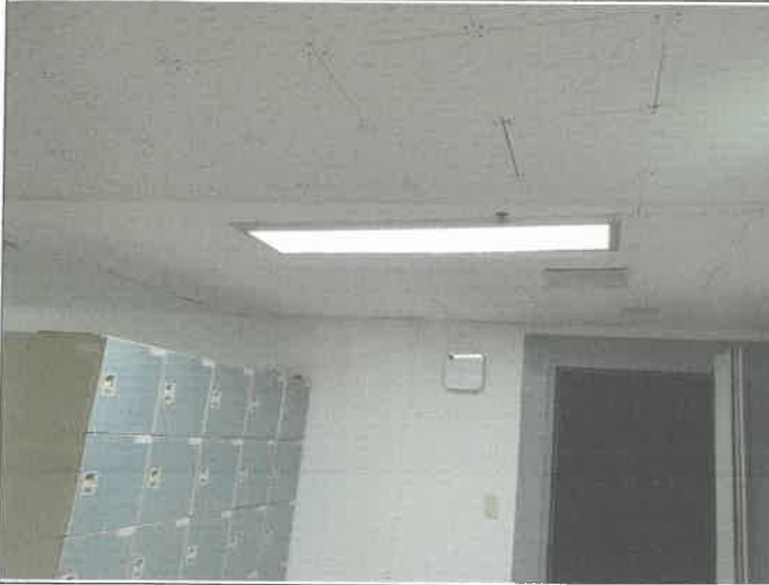
수영장 로비 천장 매립 등 1개소 교체
