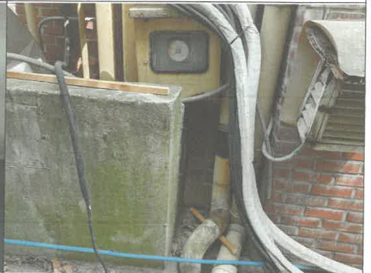
건물 후면 합물개소 옥상 우수관 연결
