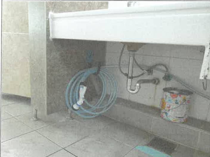
지하층. 남.여. 1층 남.여. 화장실 청소용 호수 교체 및 노즐 설치 청소 수전 교체
