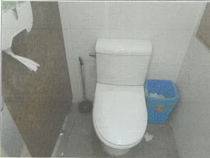
1층 남자 화장실 변기 막힘 통수
