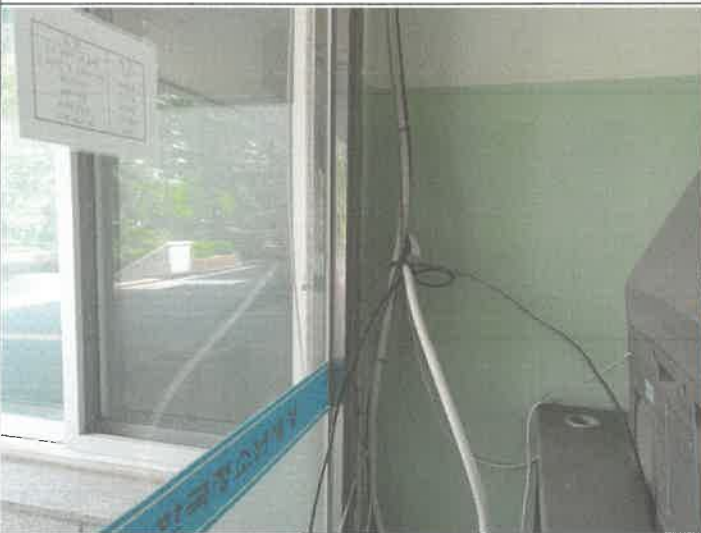
1층 현관 외부 전광등 전원 콘셋트 플러그 교체
