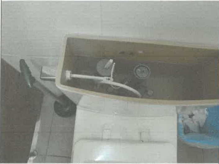
1층 남자 화장실 좌변기 1개소 싸이폰 고장 교체
