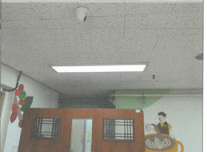
지하 1층 복도 화장실 쪽 천장 매립등 1개소 점등 불량 안전기 교체
