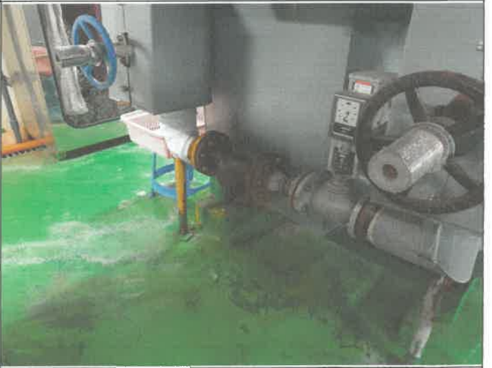
공조난방 열교환기 입구 누수로 인한 스트레이러 후렌지 패킹교체 후 조립
